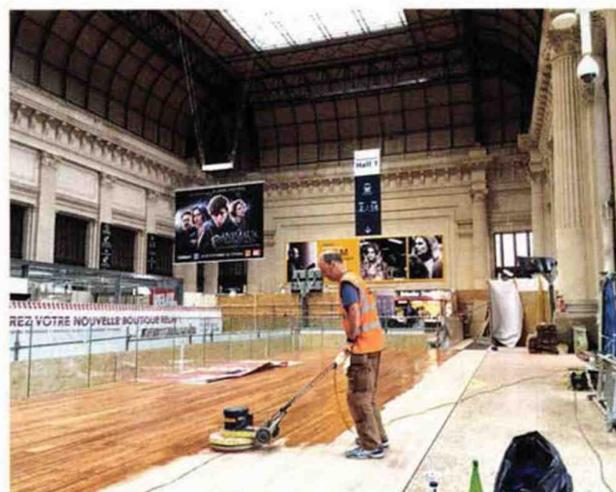
➤ La qualité de finition du ponçage et du huilage du parquet facilite les interventions ponctuelles ultérieures, dont le remplacement de lames pour des raisons de changements d'agencement ou de déplacements d'automates. Cela implique un protocole de nettoyage spécifique.
