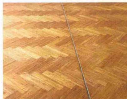
➔ Le parquet en bambou de la salle adjacente au salon d'honneur reproduit le motif à bâtons rompus : les lames Bamboo UltraDensity (15 mm d'épaisseur, largeur 9 cm, longueur 45 cm) sont collées en plein sur une chape béton.
